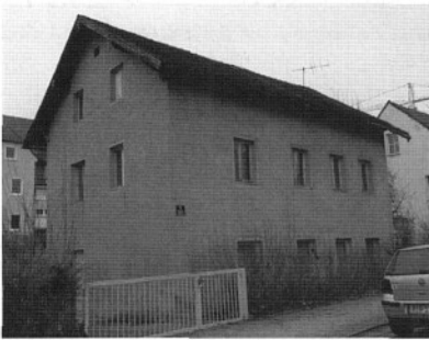
Dultplatz 1: 20 Jahre Wohnhaus mit geräumigem Hinterhof, liegt direkt am Donaukanal.
